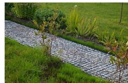
**Inštalácia:** Samotná inštalácia tvárnice je rýchla a jednoduchá. Vďaka integrovaným háčikom na okrajoch tvárnic sa jednotlivé prvky veľmi ľahko spájajú. Tvárnice sa dajú narezať na požadovanú veľkosť.
